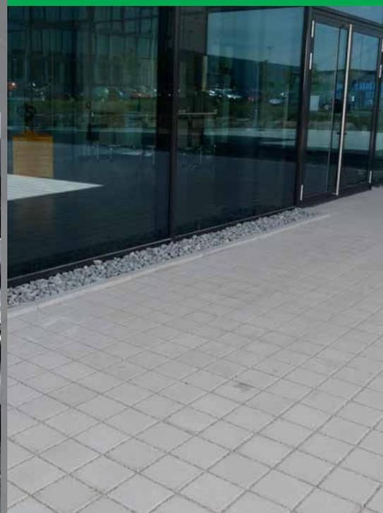
**Bild links:** Durch die ca. 11mm breiten Fugen des Steinsystems UNI-Priora® Aqua gelangt ein Großteil des anfallenden Niederschlagswassers in das Grundwasser und sorgt damit für die gewünschte ortsnahe Versickerung.
